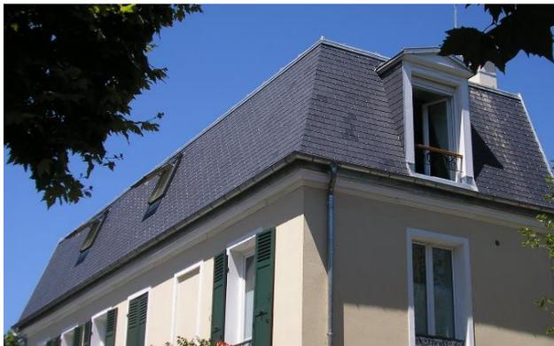
Exemple de toiture de type Mansart
